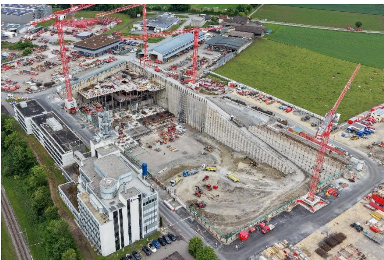
Bild: Baustelle Technologiezentrum Laufenburg
