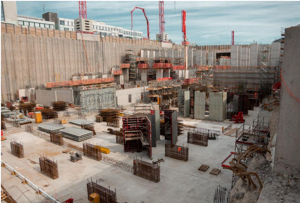
Oben: Die Arbeiten vor Ort verlaufen planmässig. Die Aushubarbeiten wurden inzwischen erfolgreich abgeschlossen. (Bildnachweis: Flex-Base)
